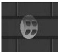
Com o auxílio de uma talhadeira ou serra copo, realize o furo central de encaixe do aparelho. Com uma furadeira e broca de  $\varnothing 6\text{mm}$  realize os furos de fixação inserindo as buchas.
